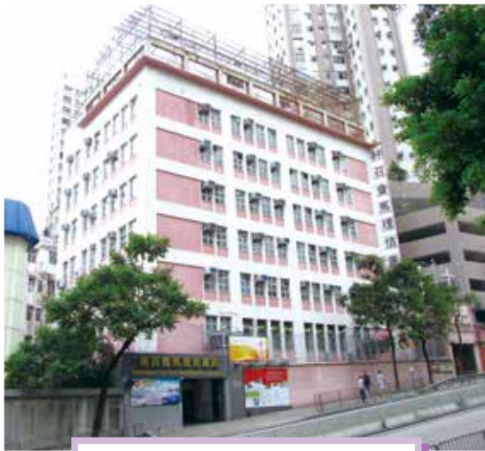
蒲崗村道91號項目 91 Po Kong Village Road Project
